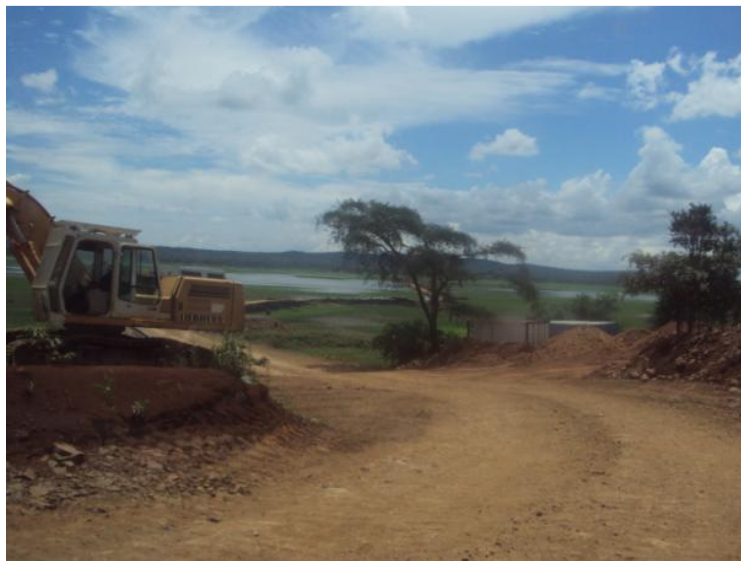
8 DIGUE ÉRIGÉE PAR MUMI SUR LA RIVIÈRE KANDO AU NIVEAU DU VILLAGE RIANDA
