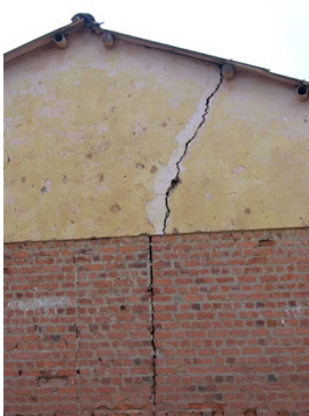
15 MAISON DONT L'EXTÉRIEUR EST FISSURÉ ET L'INTÉRIEUR S'EST PARTIELLEMENT ÉCROULÉ EN RAISONS DES EXPLOSIONS DE LA MINE T17 À MUSONOI
